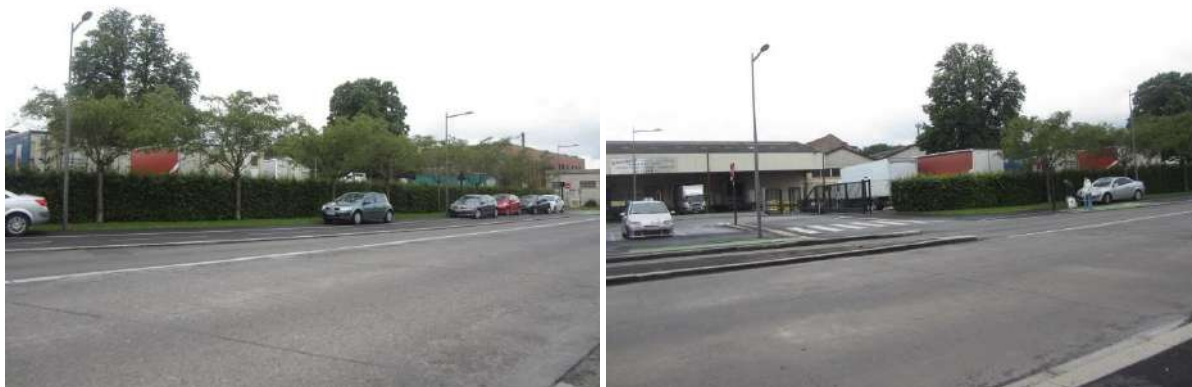
Les bâtiments économiques actuellement présents sur la zone d'étude
